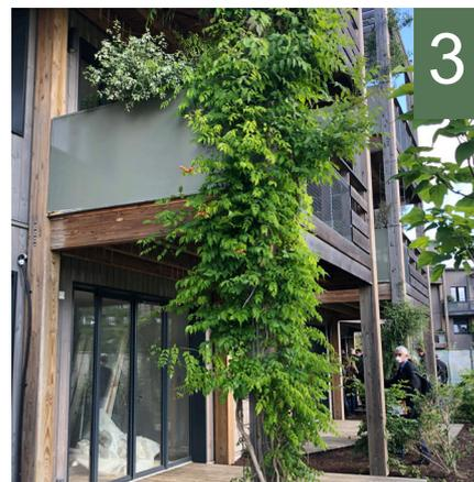
La végétalisation se fait grâce à l'installation d'une structure câbles et spirales plantées en pied d'immeuble ou avec des bacs d'appui sur la façade.
